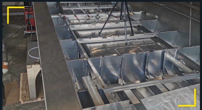
Blick in den Rumpf auf die geschweißten Spanten und die Auftriebskammern.
